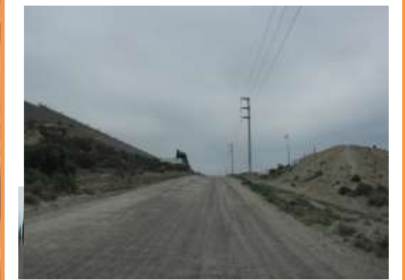
Foto 6: Continuación Avenida Juan XXIII Norte
