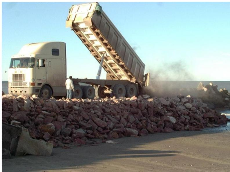
*Figura 3.19 Vuelco de Material durante la Construcción de las Escolleras de Puerto Rawson*
