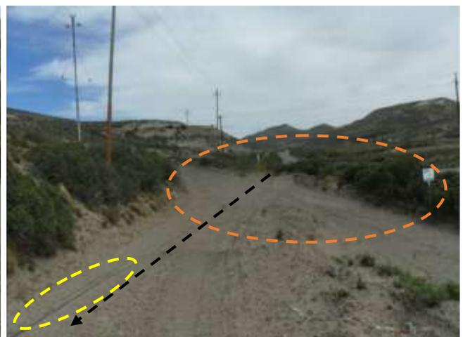
**Foto III.B-28.** Emplazamiento de oleoducto (flecha negra) por picada. Se observa ducto soterrado (óvalo amarillo) y cruce con camino de acceso del pozo G-472 (óvalo anaranjado). Foto en dirección NO.
