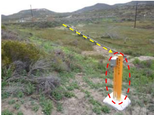
**Foto III.B-47.** Traza de oleoducto actual aéreo sobre mástil (flecha amarilla). Protección catódica de oleoducto Ex Batería 11G (óvalo rojo). Foto en dirección NO.
