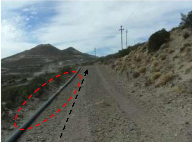
**Foto III.B-29.** Emplazamiento de oleoducto (flecha negra) por picada. Se observa cañería inactiva (óvalo rojo). Foto en dirección SE.
