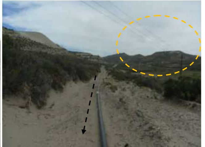
**Foto III.B-36.** Emplazamiento de oleoducto por picada (flecha negra). Se observa cruce con línea eléctrica (óvalo anaranjado) Foto en dirección NO.
