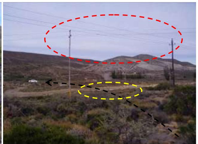
**Foto III.B-16.** Emplazamiento de oleoducto por terreno virgen. Cruce con línea eléctrica (rojo) y alambrado rural (amarillo).Foto en dirección SO.
