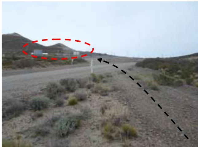
**Foto III.B-42.** Emplazamiento de oleoducto por picada existente desprovista de vegetación. Cruce con camino troncal y oleoducto Batería G 12. Cartelería de identificación del oleoducto. Fin de emplazamiento oleoducto en batería 4G (óvalo rojo). Foto en dirección SE.
