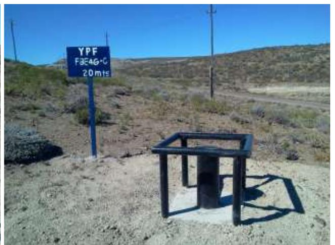
**Foto IV.1-7.** Freatímetro FBE4G-C, ubicado a unos 80 m al Noroeste de la zona de tanques de la batería, fuera de su predio, aguas abajo respecto del sentido estimado de flujo de aguas subterráneas.
