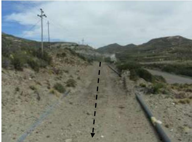
**Foto III.B-30.** Emplazamiento de oleoducto (flecha negra) por picada existente desprovista de vegetación. Foto en dirección NO.
