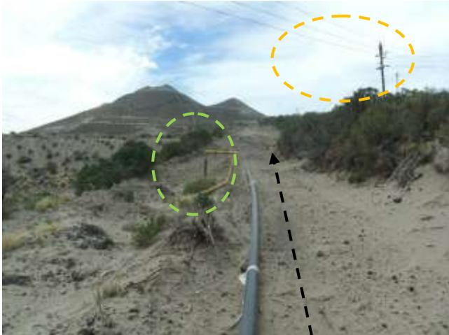
**Foto III.B-35.** Emplazamiento de oleoducto por picada (flecha negra). Se observa cruce con línea eléctrica (óvalo anaranjado) y cañería de gas (óvalo verde). Foto en dirección SE.
