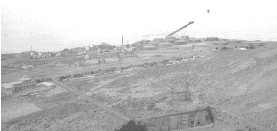
Figura 1. Playa de tanques de YPF y a la izquierda pequeña destilería de petróleo.
