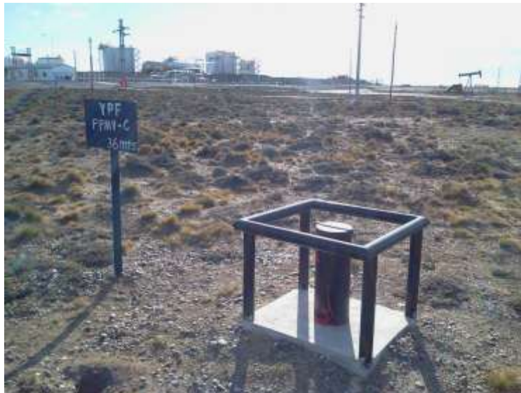
Foto IV.1-10. Freatímetro FPMV-C, ubicado a 150 m al Sureste de la planta, fuera de su predio.
