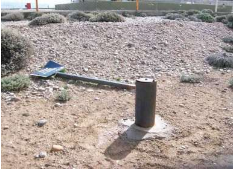
Foto IV.1-9. Freatímetro FBEAll-A, el mismo se ubica fuera del predio de la batería El Alba II. El cartel identificatorio se encuentra dispuesto sobre el suelo.
