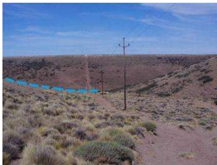
Foto IV.1-3. Foto sector oeste. Drenaje en sentido E - O en el tramo La Carolina - El Alba.
