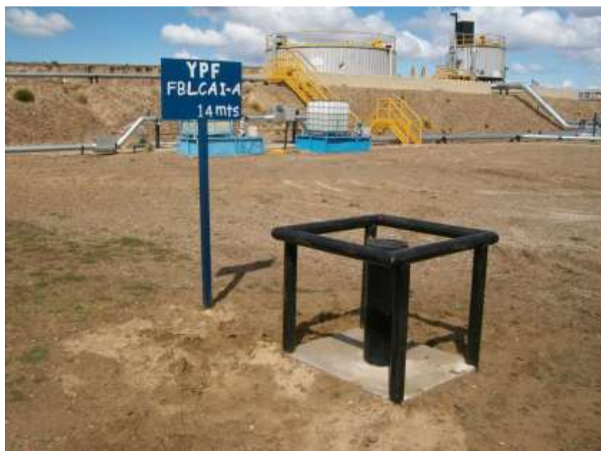
Foto IV.1-6. Freatímetro FBLCAI-A, el mismo se ubica a 20 m al Noroeste de la pileta de emergencia, dentro del predio de la Batería.
