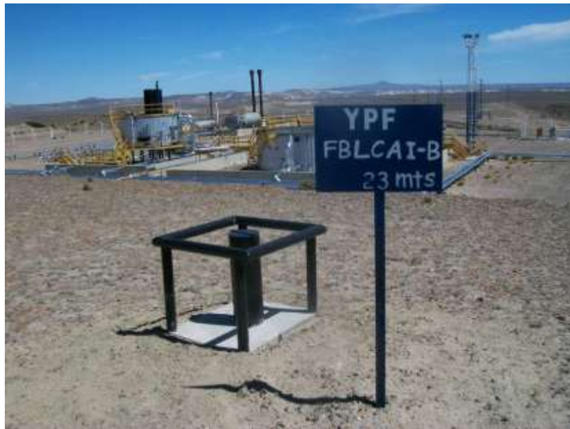
Foto IV.1-7. Freatímetro FBLCAI-B, ubicado a 25 m al Sureste de la Batería, dentro del predio de la misma.
