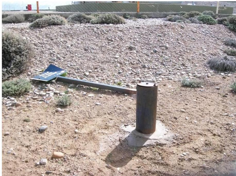
*FOTO 1: Freatímetro FBEAII-A, el mismo se ubica fuera del predio de labatería. El cartel identificatorio se encuentra dispuesto sobre el suelo.*
