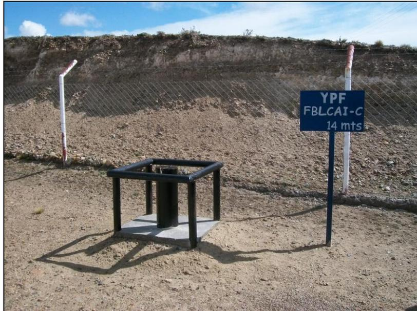
*FOTO 3: Freatímetro FBLCAI-C, ubicado 45 metros al noroeste de la zona de tanques de la Batería, dentro del predio de la misma.*
