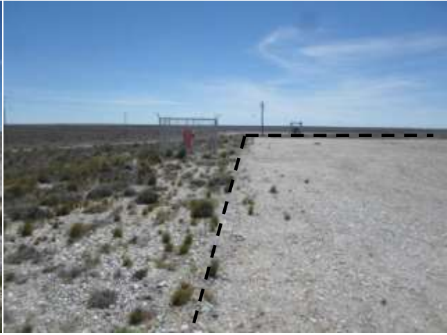
Foto III.B-57. Lateral Oeste de la locación. Foto en dirección N. Se observa equipos eléctricos.
