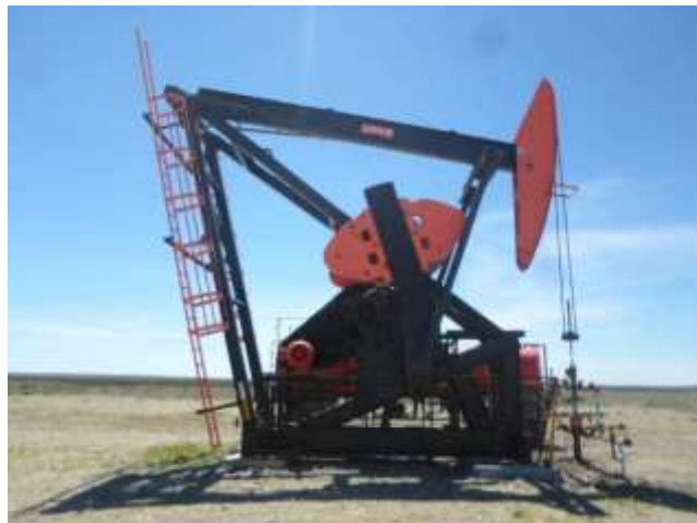
Foto III.B-80. Sistema de extracción tipo AIB. Foto en dirección N.
