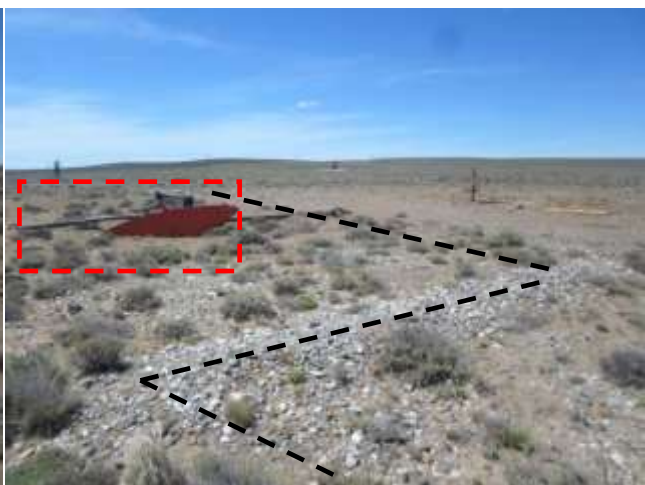
Foto III.B-35. Zona de martillo (negro). Partes del sistema de extracción tipo AIB ubicados fuera los límites de la locación (rojo). Sector de ampliación. Foto en dirección SE.
