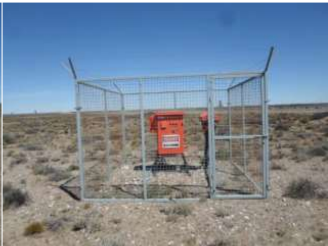
Foto III.B-31. Equipos eléctricos en lateral Oeste de la locación. Foto en dirección O.
