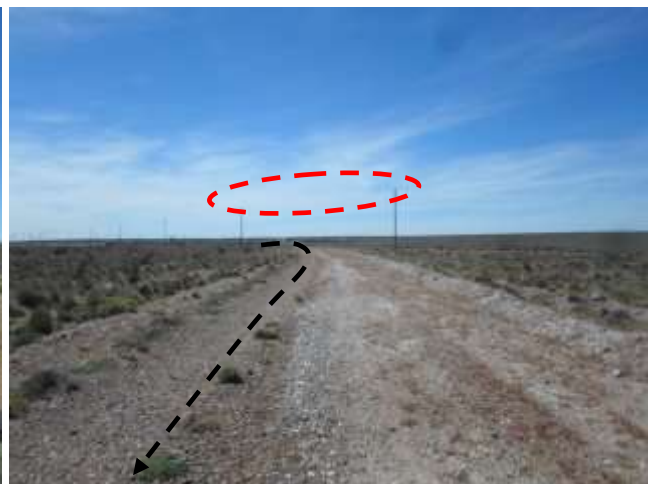
Foto III.B-6. Emplazamiento de acueducto por picada existente. Cruce con línea eléctrica. Foto en dirección SE.
