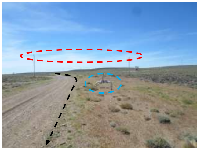
Foto III.B-24. Emplazamiento de acueducto por margen interno de camino. Cruce con línea eléctrica (rojo). Cuadro aéreo de maniobra (celeste). Foto en dirección O.
