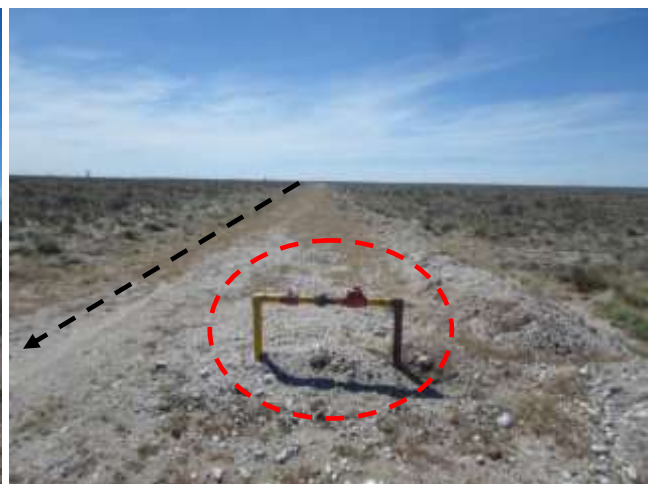
Foto III.B-8. Emplazamiento de acueducto por picada existente. Puente aéreo de gas (rojo). Foto en dirección SE.
