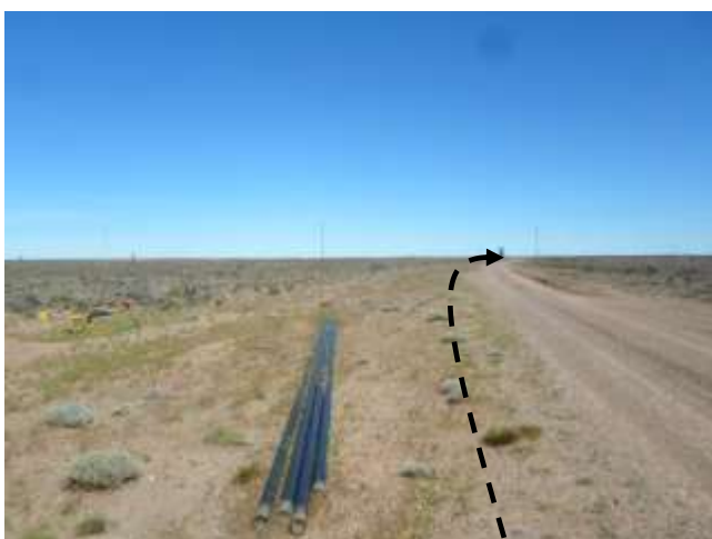
Foto III.B-25. Emplazamiento de acueducto por margen interno de camino. Foto en dirección O.
