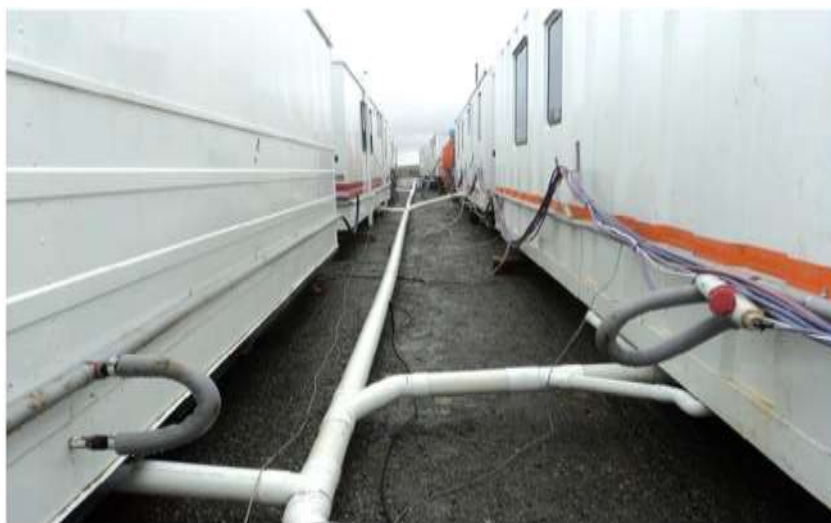
Foto III.B-92. Conexiones colectoras de efluentes crudos.
