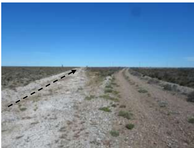
Foto III.B-7. Emplazamiento de acueducto por picada existente. Foto en dirección NE. Se observa bifurcación con camino de acceso al Pozo AEN-410.
