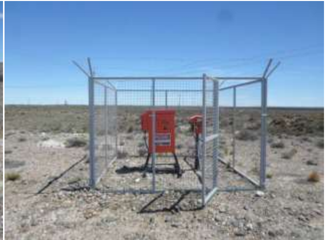
Foto III.B-79. En detalle equipos eléctricos ubicados en el lateral O de la locación.
