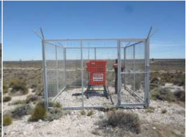
Foto III.B-63. En detalle equipos eléctricos. Foto en dirección O.
