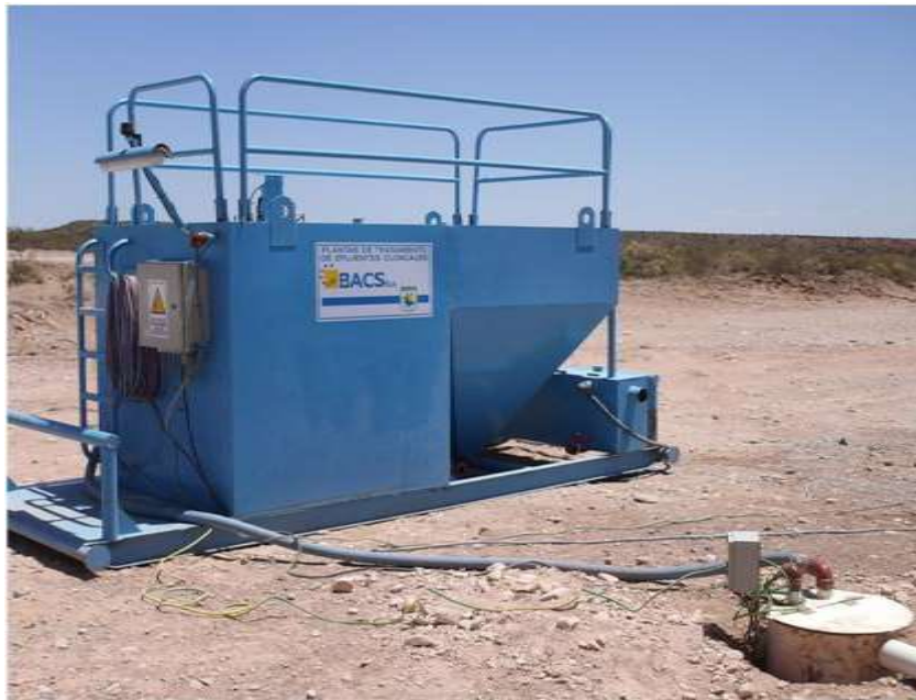
Foto III.B-93. Vista de una Planta de Tratamiento compacta.
