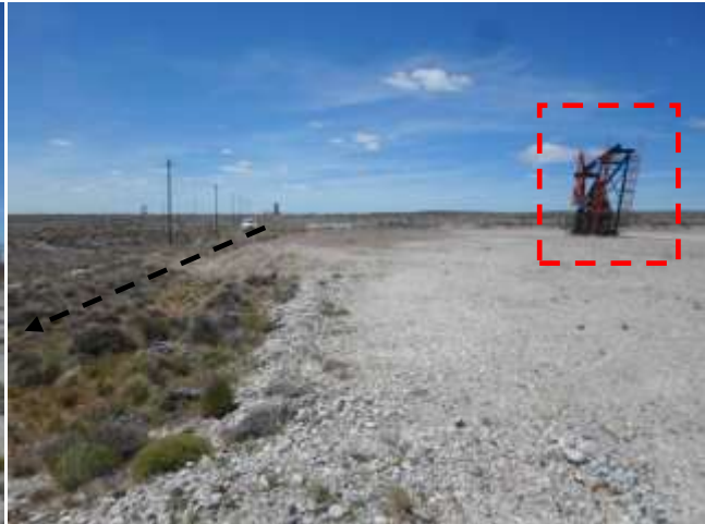
Foto III.B-84. Emplazamiento de línea de inyección por picada (parcialmente revegetada), paralela al lateral N de la locación del Pozo PCN-605. Foto en dirección E.
