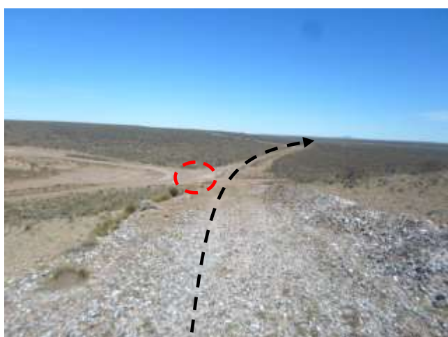
Foto III.B-13. Emplazamiento de acueducto por picada existente. Colector de gas (rojo). Foto en dirección O.
