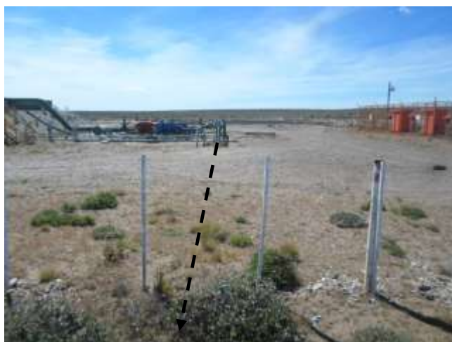
Foto III.B-1. Inicio de emplazamiento de acueducto de vinculación en PIAS EN II. Foto en dirección E.
