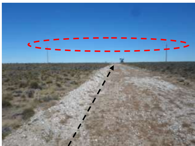
Foto III.B-9. Emplazamiento de acueducto por picada existente. Cruce con línea eléctrica. Foto en dirección NE.
