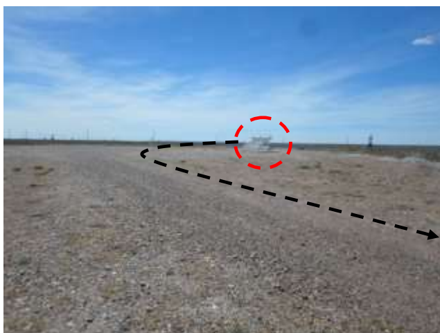
Foto III.B-10. Emplazamiento de acueducto por margen interno de camino. Colector auxiliar N° 1 EN II (rojo). Foto en dirección E.
