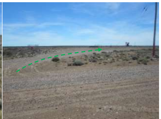
Foto III.B-29. Camino de acceso al Pozo PCN-621. Foto en dirección NE.
