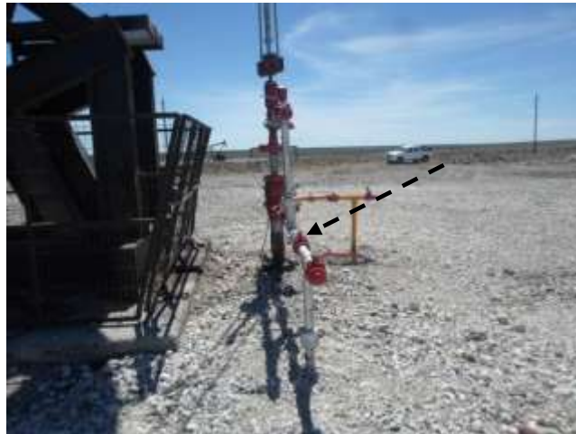
Foto III.B-70. Fin de línea de inyección en boca del Pozo Inyector PCN-605.
