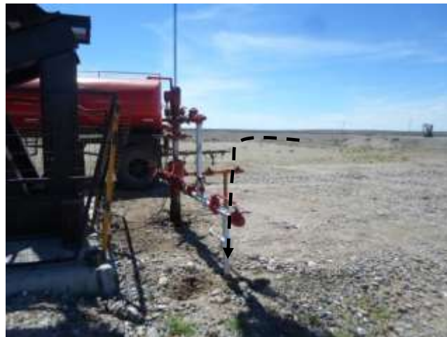
Foto III.B-91. Fin de emplazamiento de línea de inyección en la boca de Pozo PCN-624. Foto en dirección SE.
