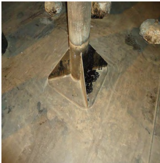
Columna central soldada fija al piso con platina
