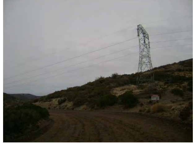
Cruce del gasoducto con LAT
