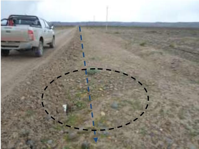
**Foto III.B-49.** Emplazamiento de línea de conducción por margen interno de camino de acceso Cruce con drenaje existente canalizado (óvalo negro). Foto en dirección E.
