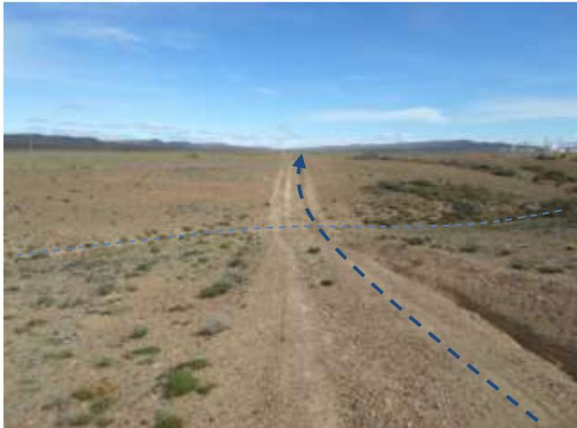
**Foto III.B-10.** Emplazamiento de acueducto por picada desprovista de vegetación. Cruce con drenaje efímero. Foto en dirección SSO.
