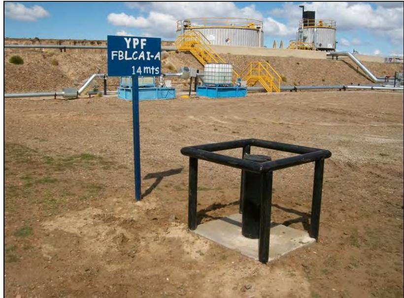
*FOTO 1: Freatímetro FBLCAI-A, ubicado 20 metros al noroeste de la pileta de emergencia, dentro del predio de la Batería.*
