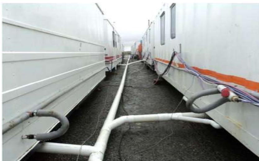
Foto III.B-53. Conexiones colectoras de efluentes crudos.
