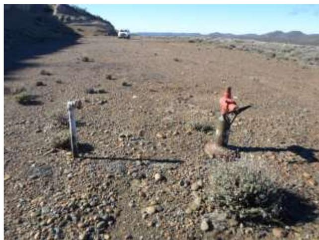
**Foto III.B-34.** Boca de pozo sin sistema de extracción asociado.
