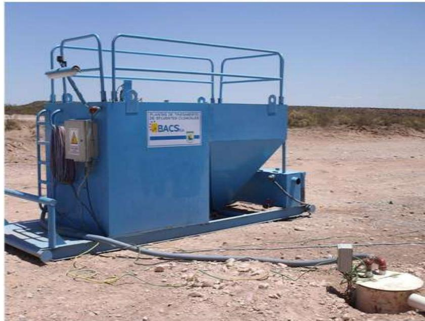
Foto III.B-54. Vista de una Planta de Tratamiento compacta.
