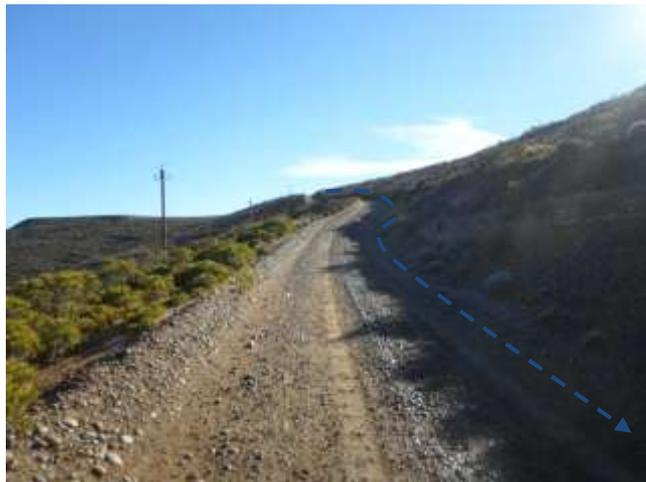
**Foto III.B-18.** Emplazamiento de línea de inyección por margen interno de camino. Se observa tendido eléctrico emplazado en margen opuesto. Foto en dirección N.
