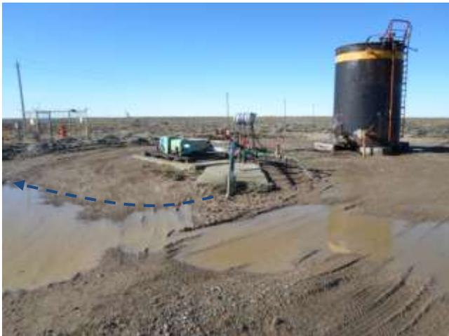
**Foto III.B-13.** Inicio de línea de inyección en puente aéreo (con bomba asociada). Foto en dirección SE.
