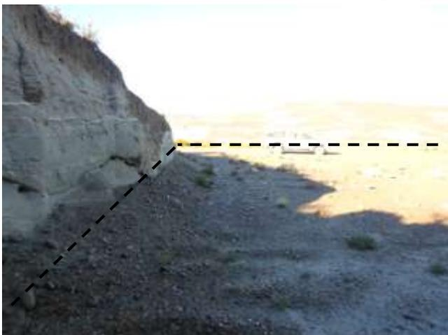
**Foto III.B-3.** Lateral N de locación. Foto en dirección E. Corte de aproximadamente 3 m de altura.
