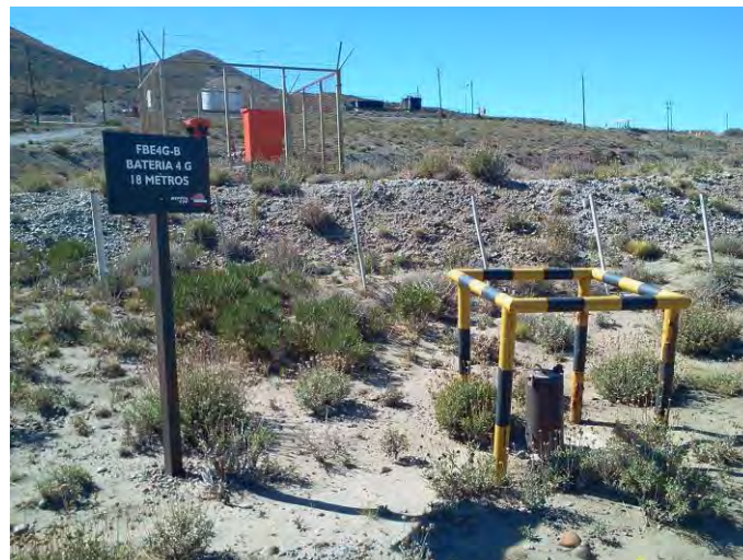
FOTO 2: Frentómetro FBE4G-B, ubicado aguas abajo de la instalación.
