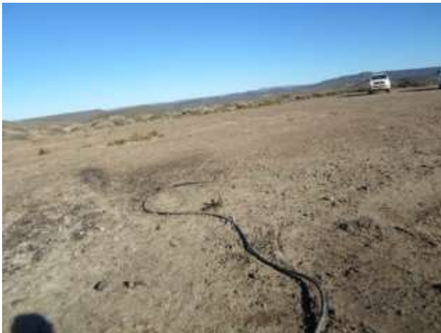
Foto III.B-24. Cable eléctrico semi soterrado y fuera de servicio a un lado de la boca del pozo.
