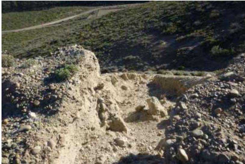
Foto IV.1-3. Fotografía tomada al Noroeste. Carcavamiento en el lateral Norte de la locación del Pozo RA-222.
