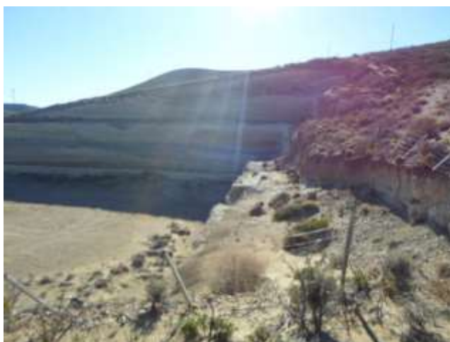
Foto III.B-21. Lateral E de locación. Se observan escalones para evitar desmoronamientos.
