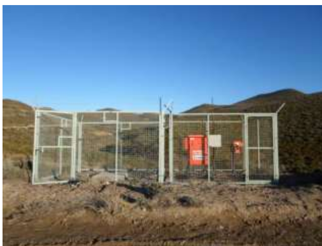
Foto III.B-45. Equipo eléctrico ubicado en lateral O de locación que abastece al sistema extracción. El mismo posee cerco perimetral.
