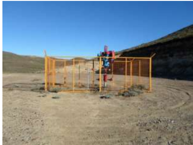
Foto III.B-82. Sistema de extracción (PCP) instalado y en funcionamiento
