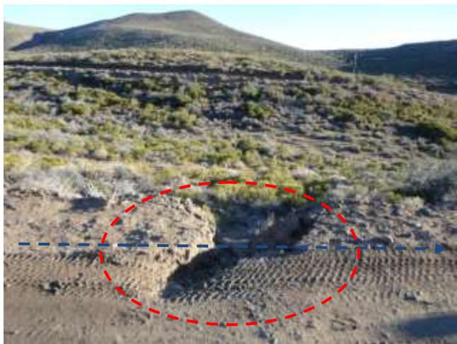
Foto III.B-67. Emplazamiento por margen interno de camino de acceso. Se observa cruce con drenaje efímero y carcavamiento a un lado del camino.
