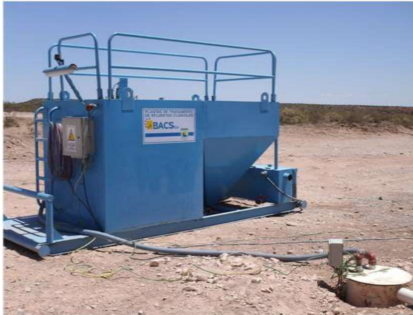
Foto III.B-107. Vista de una Planta de Tratamiento compacta.
