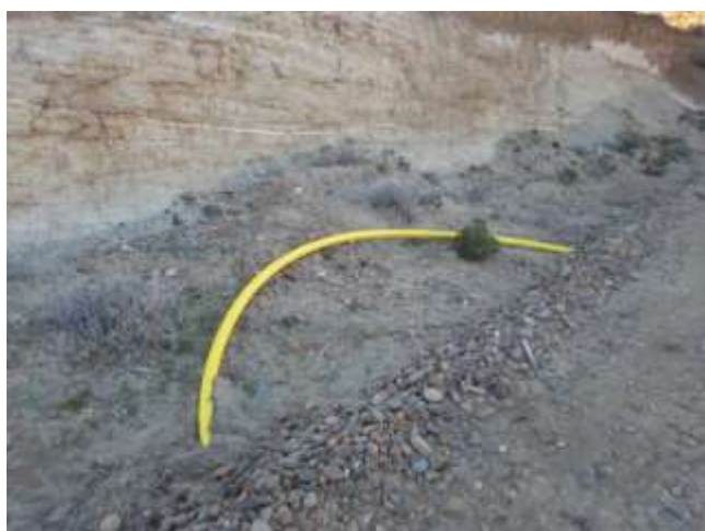
Foto III.B-44. Cañería abandonada en lateral E de locación.
