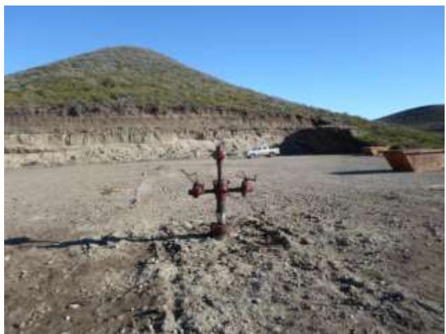
Foto III.B-96. Boca de pozo a convertir en inyector sin sistema de extracción.
