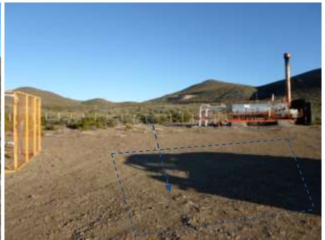
Foto III.B-14. Fin del acueducto de vinculación en futuro satélite.
