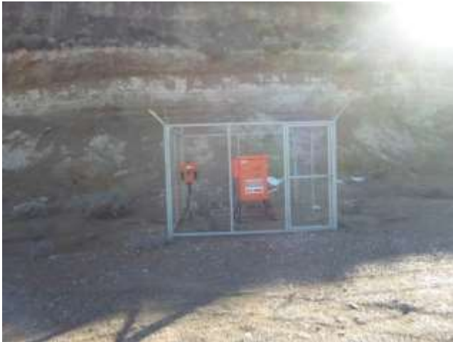
Foto III.B-80. Equipos eléctricos que abastecen de energía a sistema de extracción, ubicados en el lateral N de la locación.
