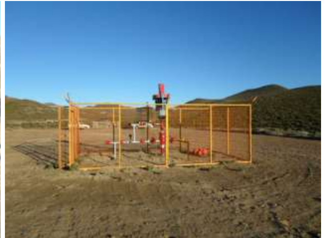
Foto III.B-47. Boca de pozo con sistema de extracción (PCP) y cerco perimetral.
