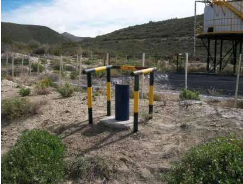
Foto IV.1-11. Freatímetro FBLB63-A ubicado al Sur de la pileta de emergencias.
