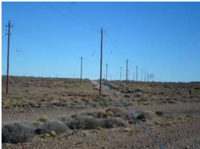
Foto III.B-30. Inicio de emplazamiento por picada existente. Cruce con líneas eléctricas. Foto en dirección O.
