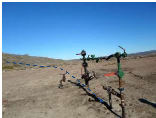
Foto III.B-37. Fin de línea de inyección en boca de pozo. Foto en dirección S.
