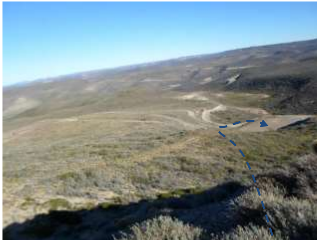
Foto III.B-35. Emplazamiento por terreno virgen luego de la picada donde se emplaza paralelo a línea eléctrica. Foto en dirección SO. Al fondo se observa locación donde finaliza la línea.
