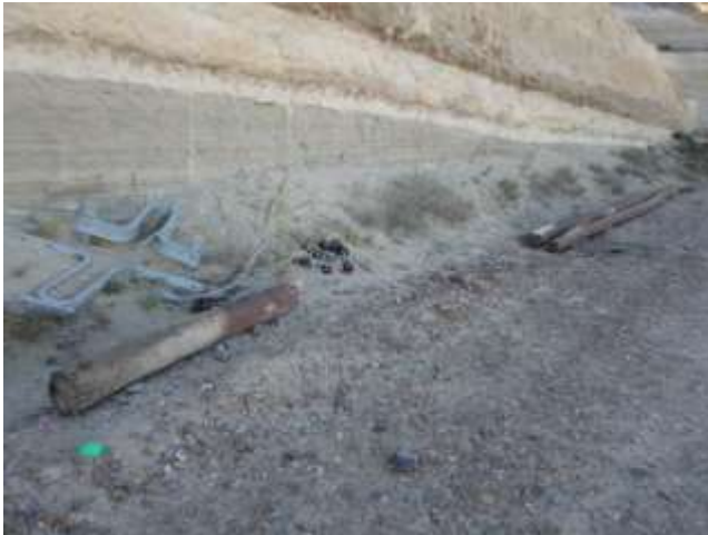
Foto III.B-22. Restos de postes eléctricos en lateral N de locación.
