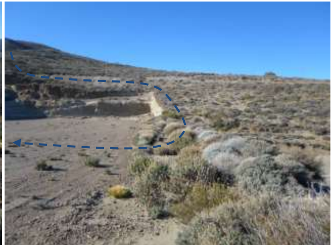
Foto III.B-36. Emplazamiento de línea de inyección por picada paralela al lateral S de la locación. Foto en dirección E.
