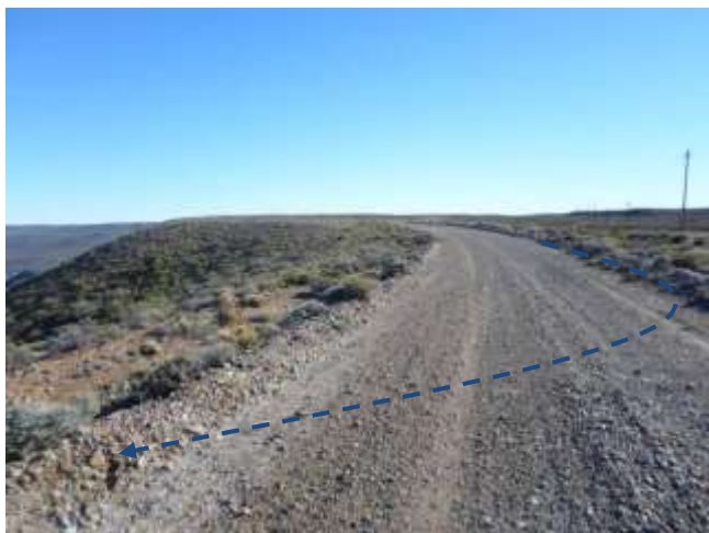
Foto III.B-32. Cruce con camino de acceso. Emplazamiento por margen interno. Foto en dirección N.
