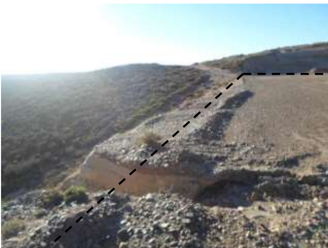
Foto III.B-57. Lateral N de locación. Foto en dirección E. Se observa presencia de cárcavas y deterioro de locación.
