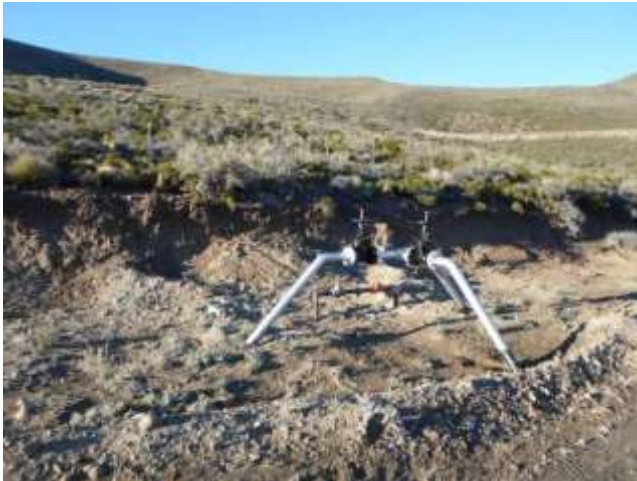
Foto III.B-46. Puente aéreo ubicado a un lado del camino de acceso al pozo (vértice SO de locación).
