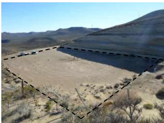
Foto III.B-20. Vista general de locación.
