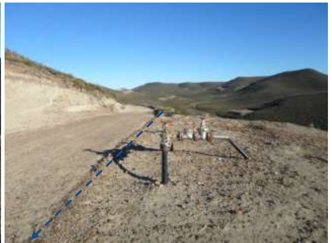
Foto III.B-73. Emplazamiento por margen interno de camino. Foto en dirección O. Se observa puente aéreo a un lado del camino de acceso al pozo.
