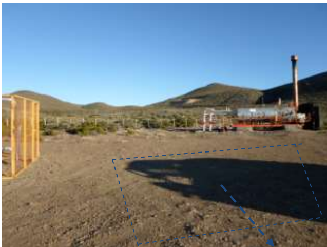
Foto III.B-48. Inicio de línea de inyección en futuro Satélite inyector N° 2.
