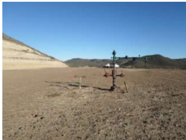
Foto III.B-63. Boca de pozo sin sistema de extracción.
