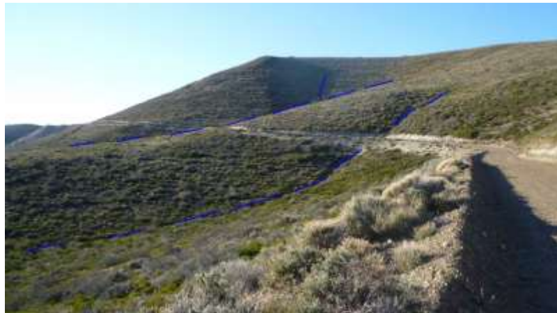
Foto IV.1-4. Drenaje 2 y 3. Foto tomada hacia el Este.
