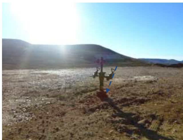
Foto III.B-105. Fin de línea de inyección en boca de pozo.
