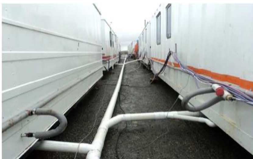
Foto III.B-106. Conexiones colectoras de efluentes crudos.
