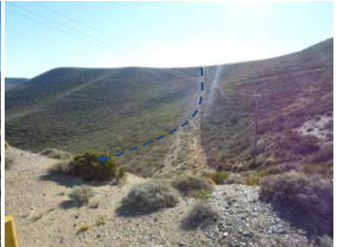
Foto III.B-34. Emplazamiento por picada existente donde se encuentra instalada línea eléctrica. Foto en dirección N. Desvío de traza por terreno virgen.
