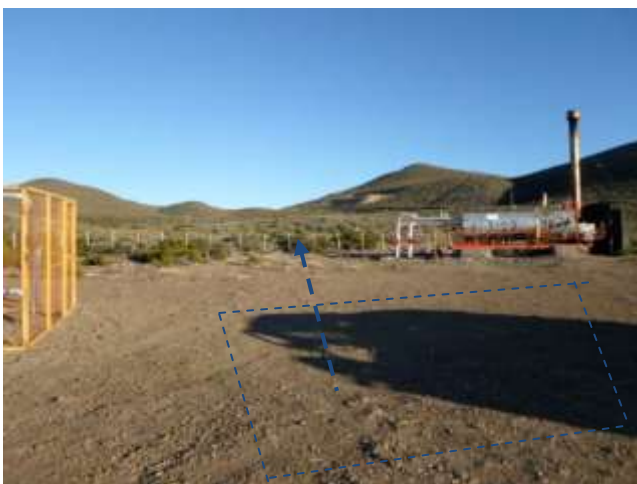
Foto III.B-83. Inicio de línea de inyección en futuro satélite inyector N° 2.
