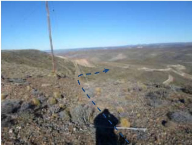
Foto III.B-33. Inicio de emplazamiento por picada existente y paralelo a línea eléctrica. Foto en dirección S.
