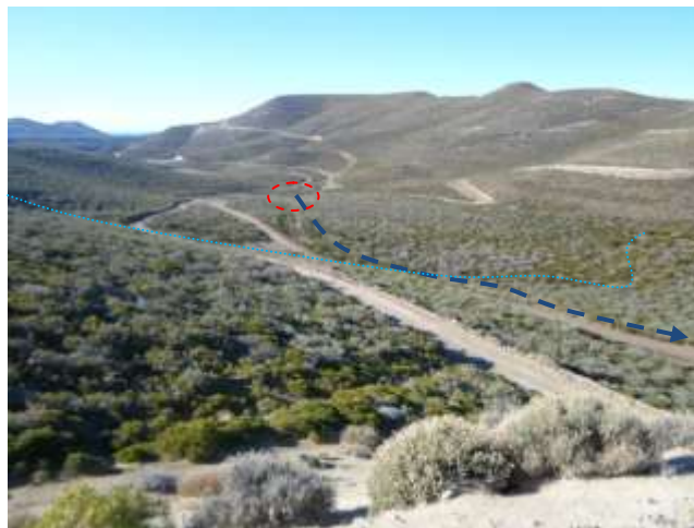
Foto III.B-99. Emplazamiento de línea por margen interno de camino. Foto en dirección O. Se observa cruce con drenaje efímero.
