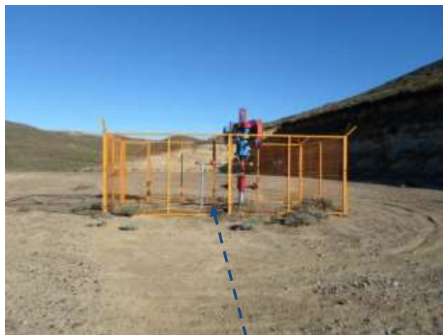
Foto III.B-89. Fin de emplazamiento de línea de inyección en futuro pozo inyector. Foto en dirección O.
