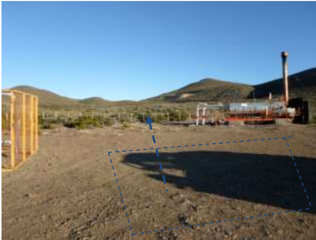
Foto III.B-97. Inicio de línea de inyección en futuro satélite inyector N° 2.
