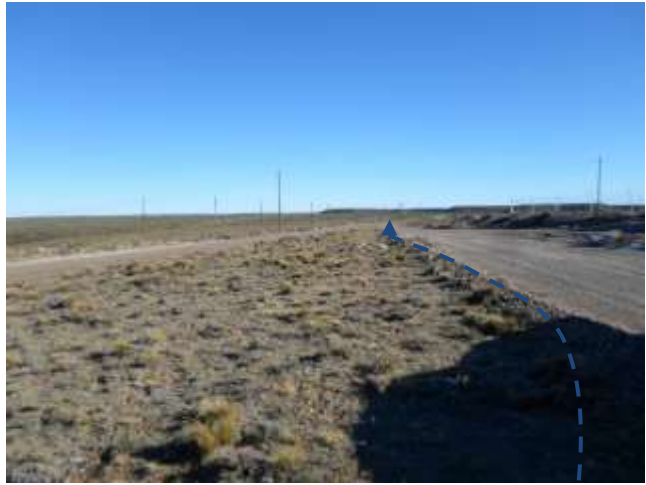
Foto III.B-28. Emplazamiento por margen interno de camino. Foto en dirección O.
