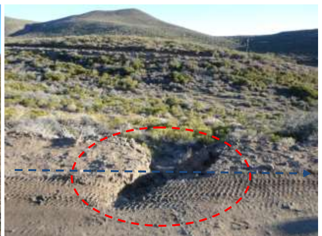
Foto III.B-51. Emplazamiento por margen interno de camino de acceso. Se observa cruce con drenaje efímero y carcavamiento a un lado del camino.
