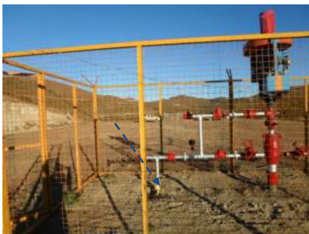
Foto III.B-53. Emplazamiento por locación. Foto en dirección O. Fin de línea de inyección en boca de pozo.
