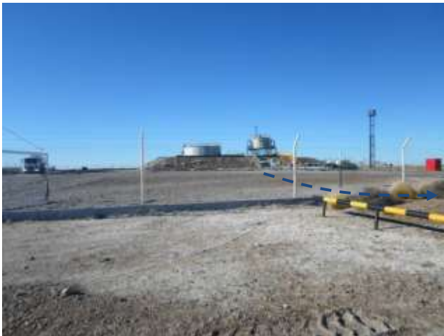
Foto III.B-1. Inicio de acueducto de vinculación entre Batería San Carlos y futuro satélite N° 1 SC. Foto en dirección E.
