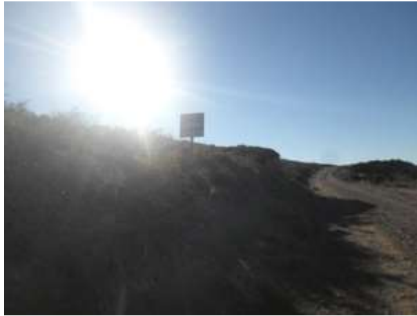
Foto III.B-75. Camino de acceso a pozo y cartelería de identificación.
