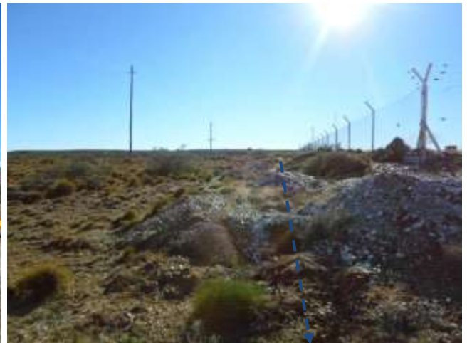
Foto III.B-2. Emplazamiento de acueducto de vinculación por terreno alterado. El sitio corresponde al lateral O de la locación de la Batería San Carlos. Foto en dirección N.
