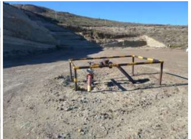
Foto III.B-25. Cuadro de maniobras ubicado próximo al vértice NO de la locación.
