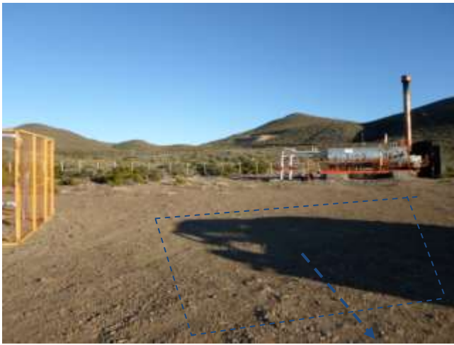
Foto III.B-64. Inicio de línea de inyección en futuro Satélite inyector N° 2.
