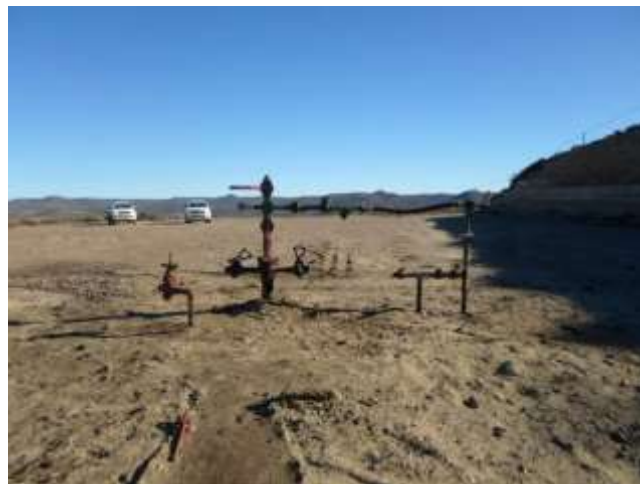
Foto III.B-26. Boca del pozo. Se observa puente de inyección.
