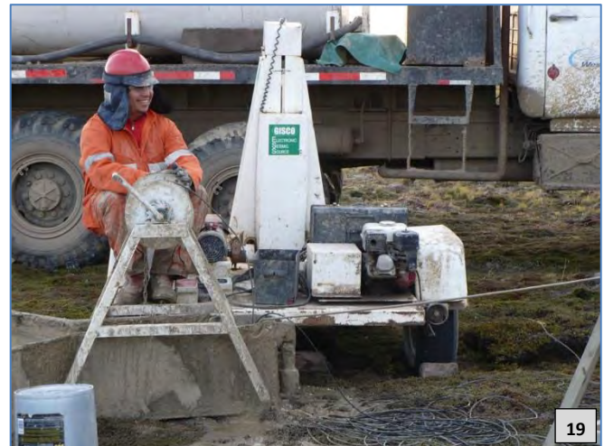
Fotografía 19. Equipamiento de registro en Up Holes.
