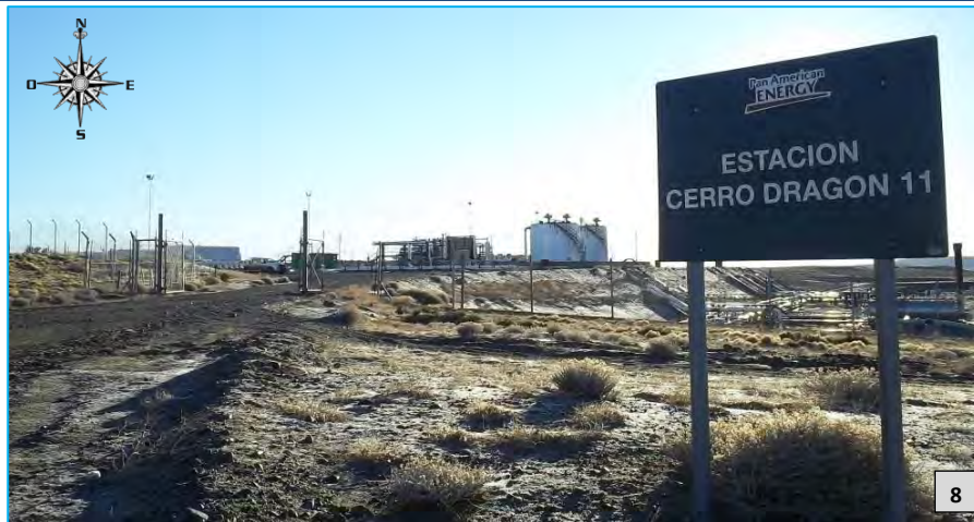
Fotografía 8. Vista general hacia el sector N, donde se observa la Estación CD-11.
