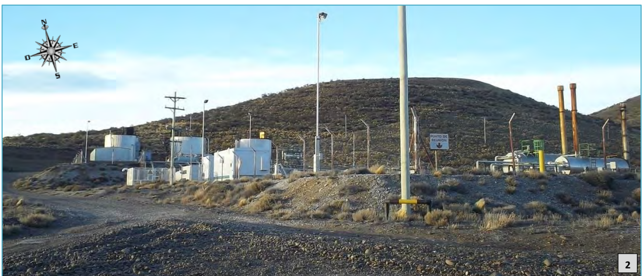
Fotografía 2. Vista general hacia el sector NNE, donde se observa la Batería Pampa 1.
