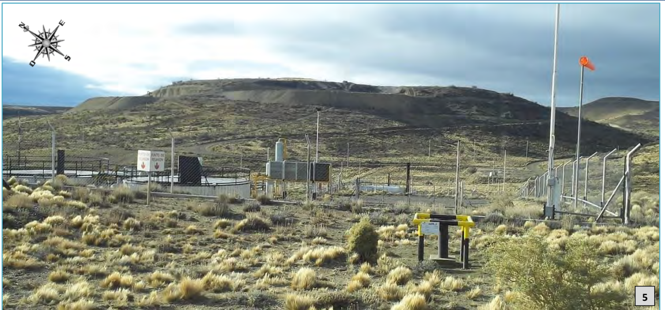
Fotografía 5. Vista general hacia el sector NE, donde se observa la Batería LP-1.
