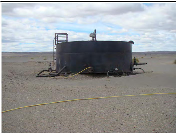
Foto 16 En locación de pozo EaGOa-1 se observó tanque sobre superficie, con base socavada. Punto 7
