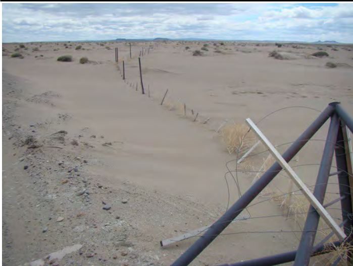
Foto 2 Alambrado rural en malas condiciones. Fotografía en dirección E Punto 1
