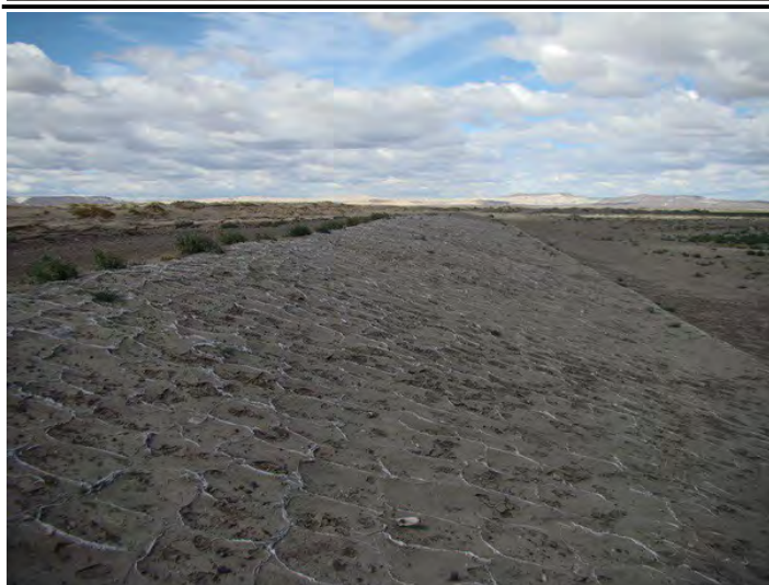
Foto 18 Talud construido por acopio de bolsas para la confección de un terraplen o muro de contención al margen del camino. Punto 9
