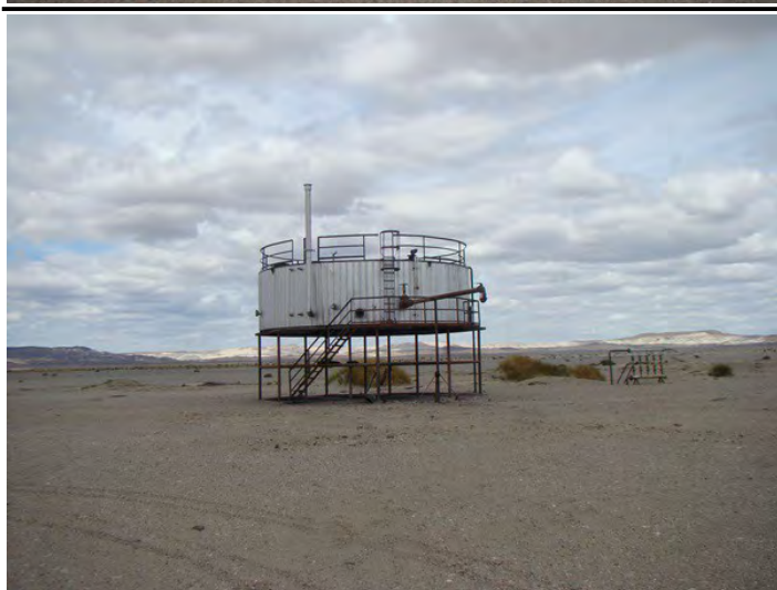
Foto 12 En locación de pozo PV-2 se observó la instalación de otro tanque elevado y un Colector auxiliar. Punto 6
