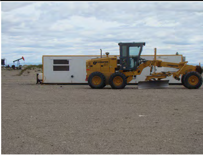
Foto 13 En locación de pozo PV-2 se observó el montaje de un trailer. Punto 6
