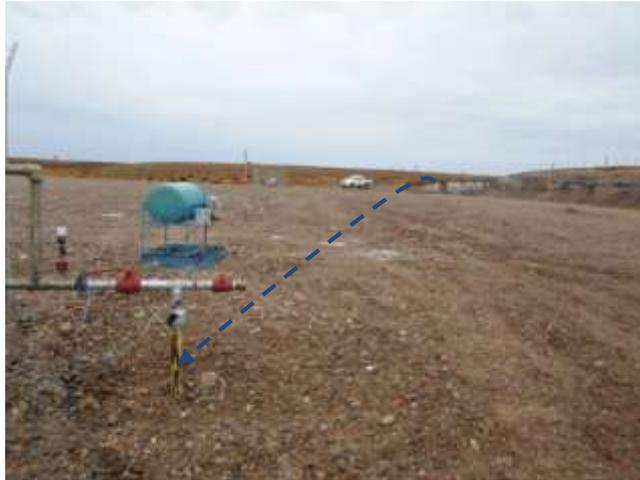
Foto III.B-116. Fin de línea de inyección en boca de pozo.
