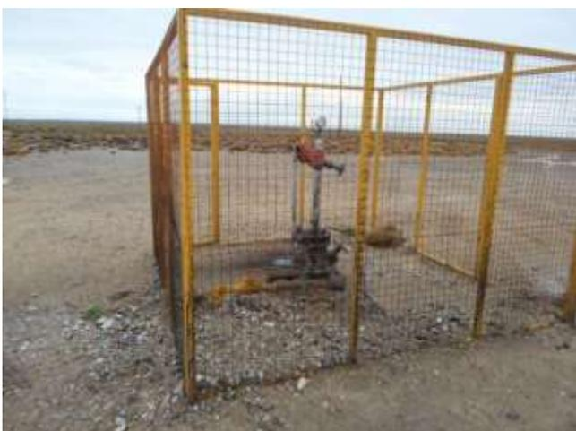
Foto III.B-58. Boca de pozo sin sistema de extracción instalado. Pozo inactivo.
