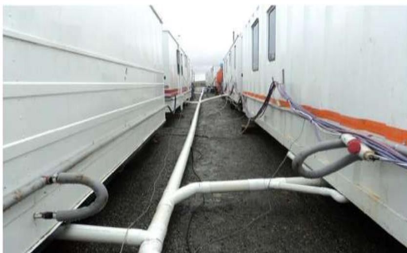
Foto III.B-142. Conexiones colectoras de efluentes crudos.
