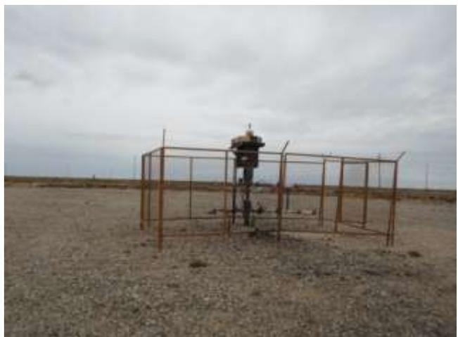
**Foto III.B-99.** Sistema de extracción (PCP) instalado y en funcionamiento con cerco perimetral.
