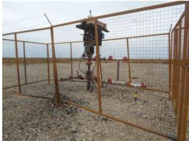
Foto III.B-102. Fin de línea de inyección en boca de pozo.
