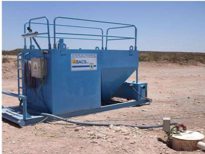
Foto III.B-143. Vista de una Planta de Tratamiento compacta.
