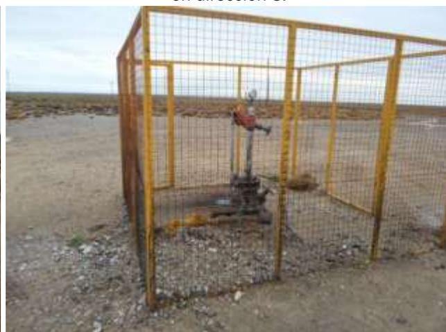
Foto III.B-63. Fin de línea de inyección en boca de pozo actualmente inactivo.
