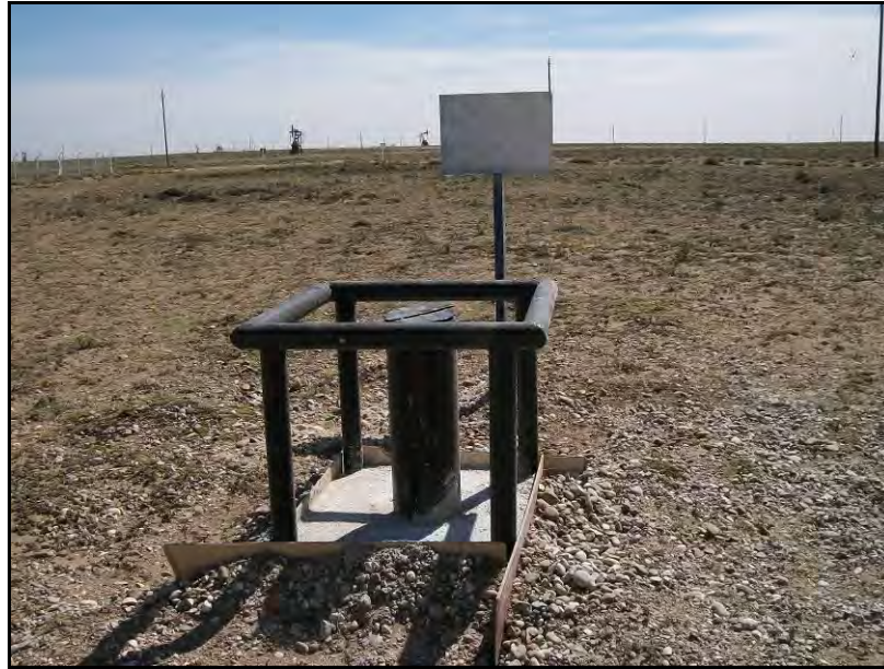
FOTO 3: Freatímetro FBLCII-C, ubicado al noreste de la zona de tanques de la batería, fuera de su predio. Su cartel de identificación se encuentra sin pintar.
