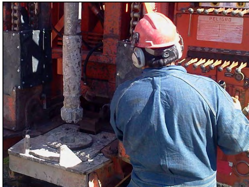
FOTO 4: Máquina Perforadora DRILLTECH D- 40 KK. Como se puede observar en la fotografía, la broca empleada en la perforación es una fresa (PDC) de 6 ½ pulgadas de diámetro.
