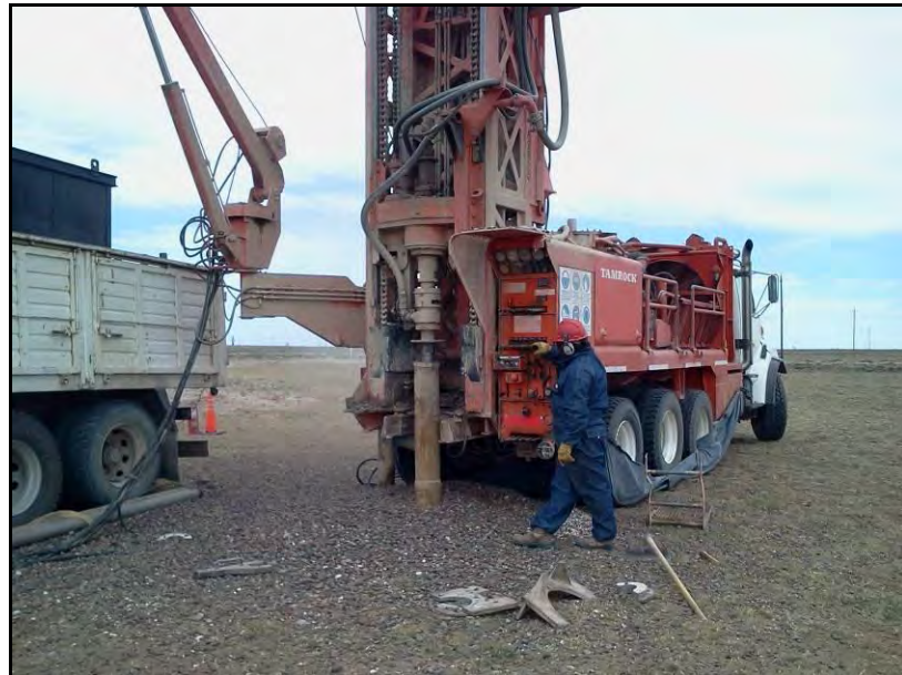
FOTO 5: Tarea de encamisado del pozo utilizando casing de acero, de 8 pulgadas de diámetro.
