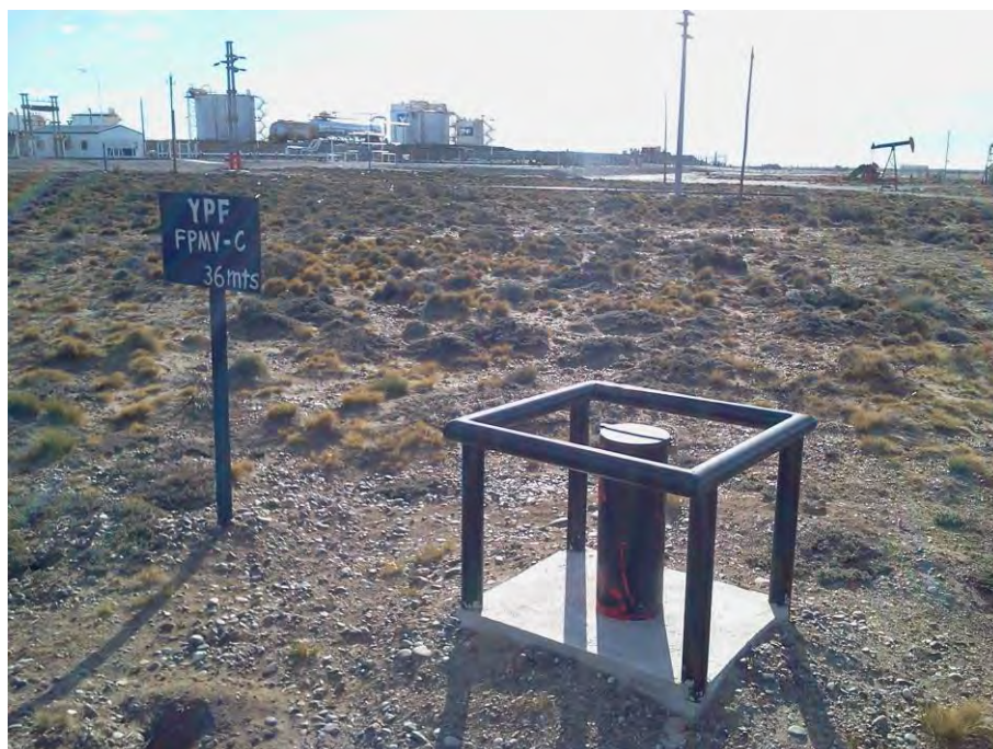
FOTO 4: Freatímetro FPMV-C, ubicado 150 metros al sureste de la planta, fuera de su predio.
