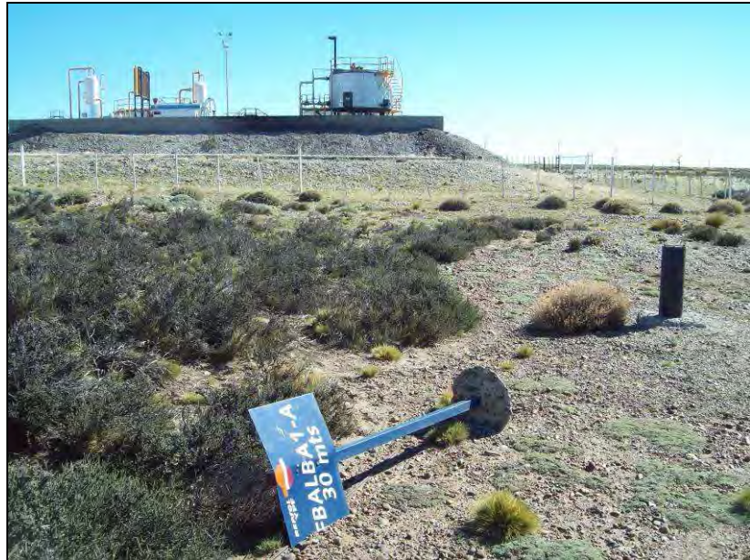
FOTO 1: Freatímetro FBEAI-A, ubicado al sureste de la pileta de emergencias de la instalación, fuera de su predio. Su cartel identificador se encuentra en el suelo.
