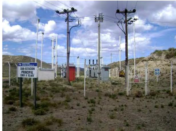
Subestación eléctrica principal con alambrado perimetral, portón con candado, cartel de identificación y de utilización de EPP.
