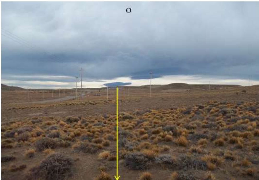
Foto 11.62. Progresiva km 2,520. La traza continúa su desarrollo ascendiendo por un terreno con pendiente negativa del 10% hacia el SO y cruza un camino. Este camino vuelve a cruzarse en la Progresiva km 2,705. Vista al O.
