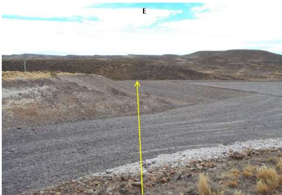
Foto 11.90. En la Progresiva km 6,954 la traza es atravesada por un camino de acceso a un pozo y 40 m más adelante se desarrolla a través del sector achicado y escarificado de la locación. Vista al E.
