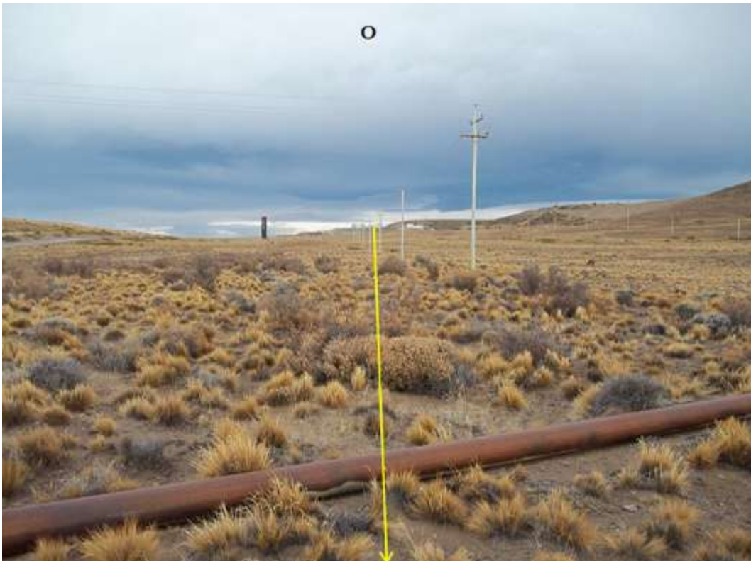
Foto 11.57. Progresiva km 1,880. Ducto aéreo que interfiere con la traza. En segundo plano, cruce de dos líneas eléctricas. Vista al O.
