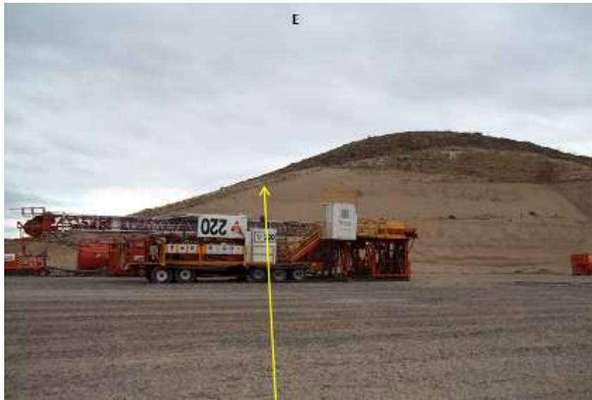
Foto 11.105. Progresiva km 10,440. La traza atraviesa la locación del Pozo Z-968 y los taludes de bote y corte de la misma. Ambos taludes presentan alturas de más de 3 m de altura. Vista al E.
