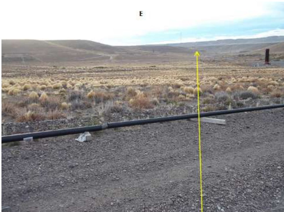
Foto 11.56. Progresiva km 1,315. La traza cruza un camino y luego una cañería desfilada. Vista al E. En las Progresivas km 1,760 y km 1,810 la traza cruza líneas eléctricas y en la Progresiva km 1,880 se observó el cruce de un ducto aéreo que también interfiere con la traza (Foto 11.59).
