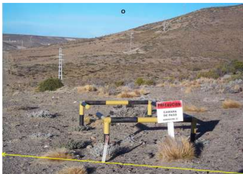
Foto 11.7. Vista al O desde la Progresiva km 4,850. La traza se desarrolla junto a una cámara de paso subterránea que presenta barreras de protección.
