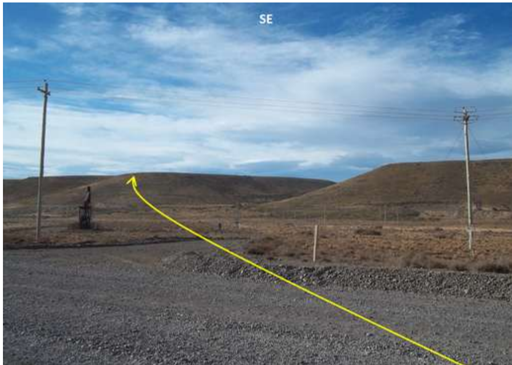
Foto 11.74. Progresiva km 3,910. Locación y camino de acceso del Pozo Z-850, los cuales interfieren con la traza. Vista al SE.
