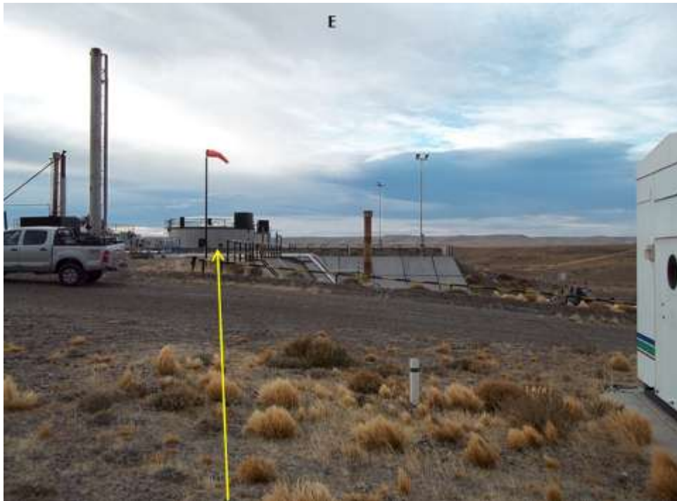
Foto 11.55. Progresiva km 1,160. La traza cruza un camino y, posteriormente, las instalaciones de la Batería TP1. Vista al E.
