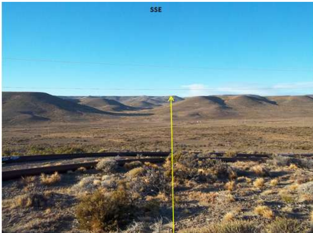
Foto 11.8. Vista al SE desde la Progresiva km 4,880. Se observan dos ductos aéreos y una línea eléctrica que interfieren con la traza.
