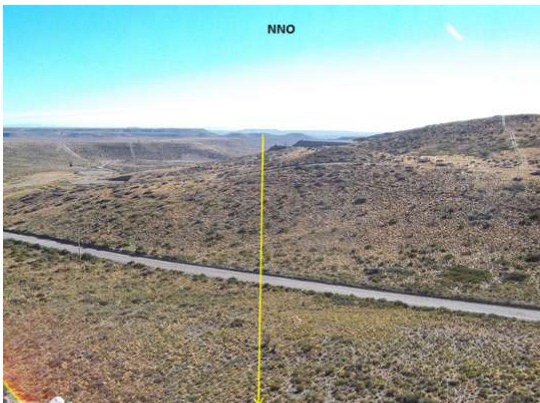
Foto 11.29. Vista al NO desde la Progresiva km 10,230, sobre una locación que interfiere con la traza.
