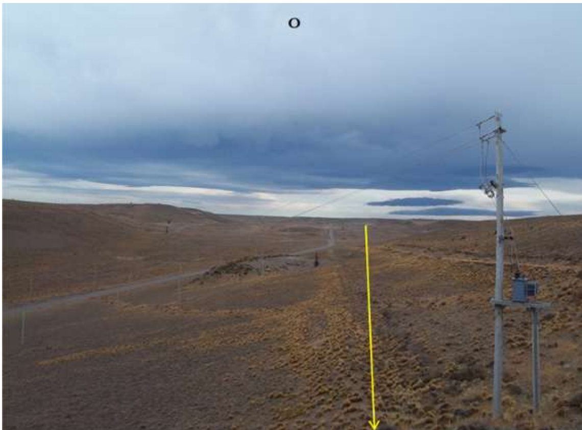
Foto 11.65. Progresiva km 3,280. Vista al O desde el talud de bote de la locación del Pozo Z-52. La traza cruza una línea eléctrica 10 m más atrás.
