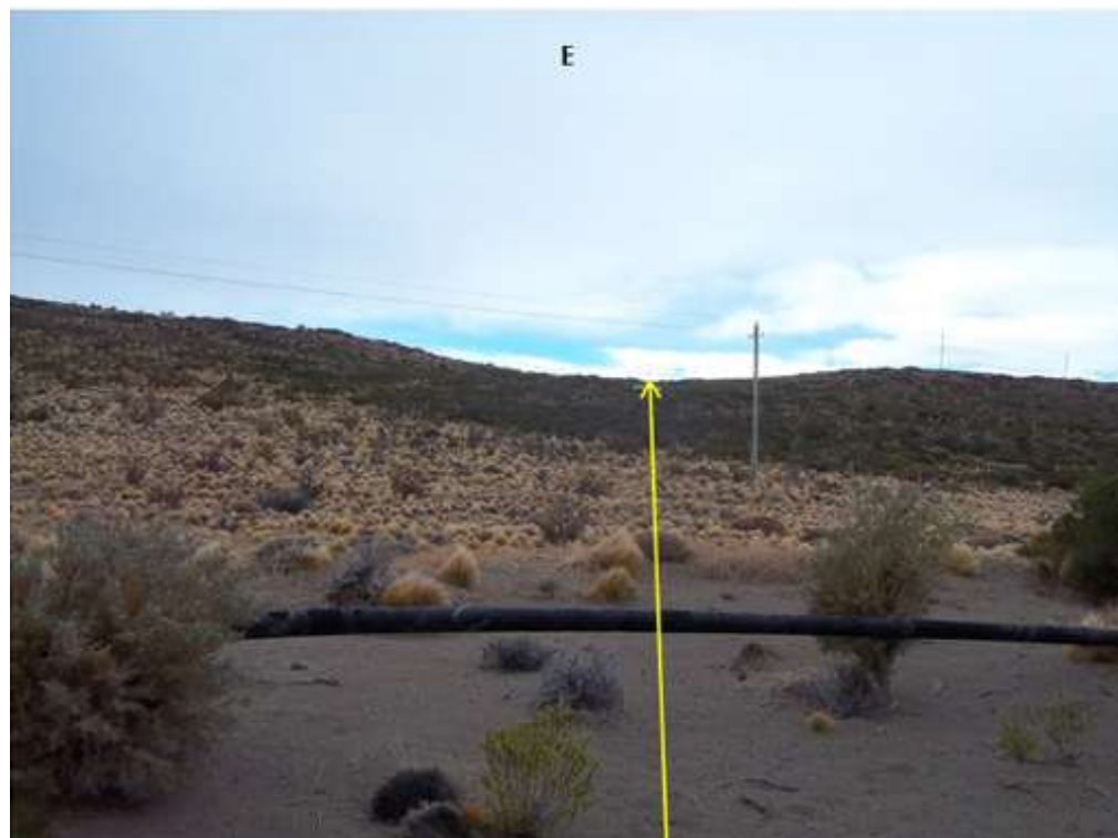
Foto 11.96. Progresiva km 8,570. La traza es atravesada por un ducto aéreo. Vista al E.
