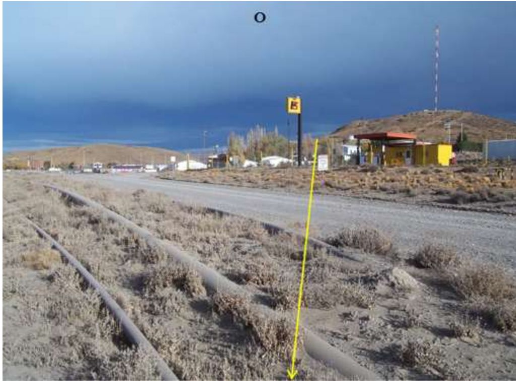
Foto 11.73. Progresiva km 3,830. En primer plano se observan 3 ductos aéreos que interfieren con la traza, detrás un camino principal del yacimiento y, en último plano, el predio con surtidores de Petrosar y el campamento de Skanska, que interfieren con la traza. Vista al O.
