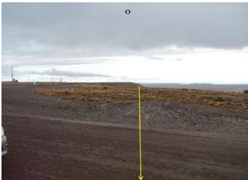
Foto 11.106. Progresiva km 11,050. La traza transcorre ahora por la meseta de la Pampa del Castillo y cruza un camino del Yacimiento. Vista al O.
