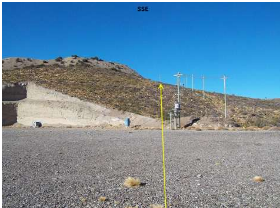
Foto 11.25. Vista al SE desde la Progresiva km 9,360. Se observa la locación del Pozo Z-1071, la cual interfiere con la traza. Posteriormente, la traza asciende una pendiente de aproximadamente 30%. Aproximadamente en la Progresiva km 9,550, la traza atraviesa la línea eléctrica que se observa en la imagen.
