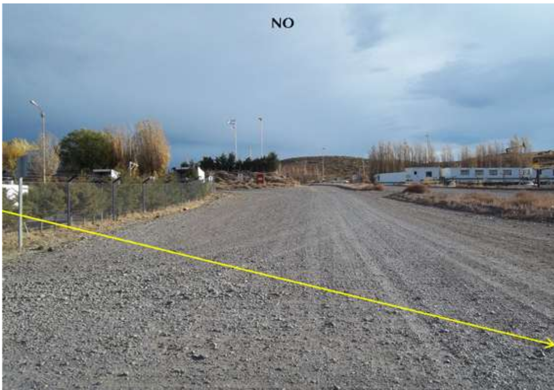
Foto 11.71. Progresiva km 3,740. Cruce de camino. Vista al NO.
