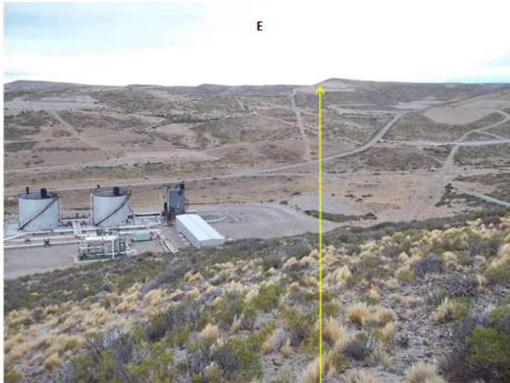
Foto 11.101. Progresiva km 9,220. La traza atraviesa un cañadón y transcurre a través de pendientes de hasta 25%. Se observa la Batería Z3, la cual no interfiere con la traza, la locación del Pozo Z-110, la cual sí interfiere con la traza, y el cruce de dos caminos del Yacimiento en el fondo del cañadón. Vista al E.
