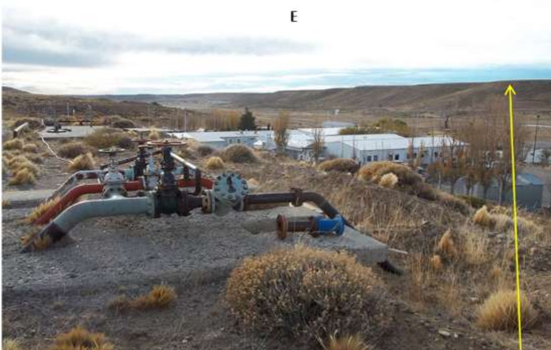
Foto 11.69. Progresiva km 3,530. La traza transcurre a 1-2 m de las llaves y válvulas, asociadas a los tanques previamente mencionados, que se observan en la imagen, para luego descender por el talud de la locación de dichos tanques hacia el Campamento Tres Picos, el cual interfiere con la traza. Vista al E.
