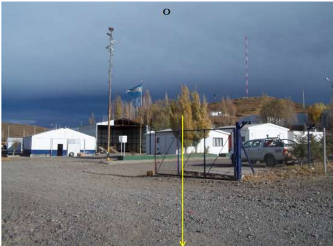
Foto 11.70. Progresiva km 3,740. La traza atraviesa una zona de estacionamiento de vehículos y luego cruza el campamento de Skanska, el cual se observa en la imagen. Vista al O.
