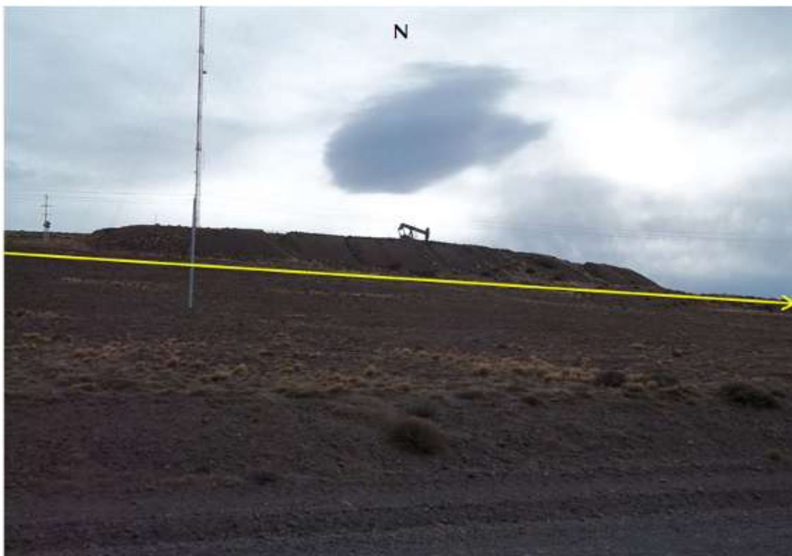
Foto 11.66. Progresiva km 3,260. Talud de bote de la locación del Pozo Z-52, el cual interfiere con la traza. Vista al N.
