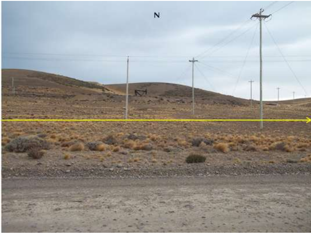
Foto 11.61. Progresiva km 2,390. La traza se desarrolla paralela a un camino principal del Yacimiento y cruza dos líneas eléctricas. Vista al N.
