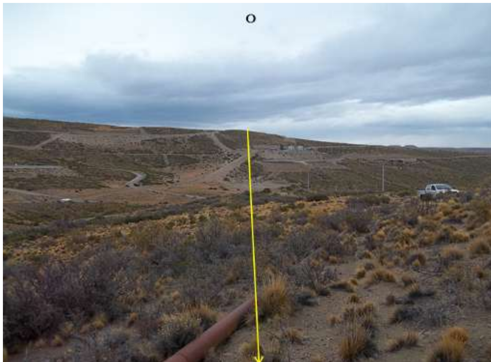
Foto 11.102. Progresiva km 10,090. La traza es atravesada por un ducto aéreo y una línea eléctrica. Vista al O.
