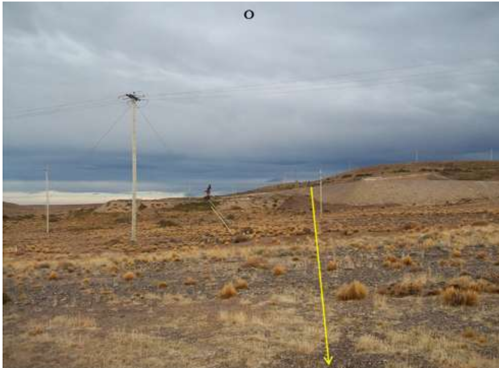
Foto 11.54. Progresiva km 1,160. A la derecha se observa la locación del Pozo TP-918, la cual interfiere con la traza. Se observa un talud de aproximadamente 3 m de altura. La locación que se observa al fondo en el centro de la imagen no interfiere con la traza. También se observan dos líneas eléctricas atravesadas en las Progresivas km 1,110 y km 1,140. Vista al O.
