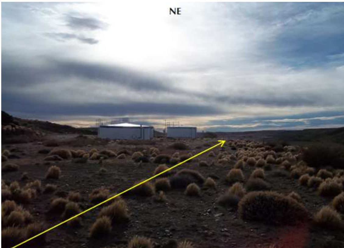
Foto 11.68. Progresiva km 3,480. La traza continúa su recorrido por una locación de tanques elevados, la cual se encuentra revegetada, aunque el suelo se observó compactado. La traza transcurre a unos 10 m de los tanques, los cuales no interfieren con la misma. Vista al NE.
