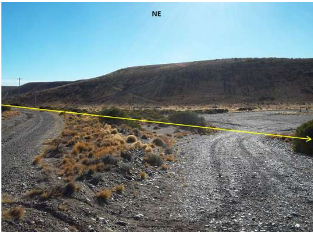
Foto 11.20. Vista al NE, altura Progresiva km 8,340. La traza atraviesa el camino de acceso al Pozo Z-185.
