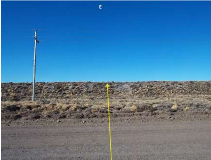
Foto 11.127. Progresiva km 16,650. La traza atraviesa un camino del Yacimiento y posteriormente cruza una línea eléctrica y el terraplén del viejo ferrocarril, el cual tiene aproximadamente 2 m de altura. Vista al E.
