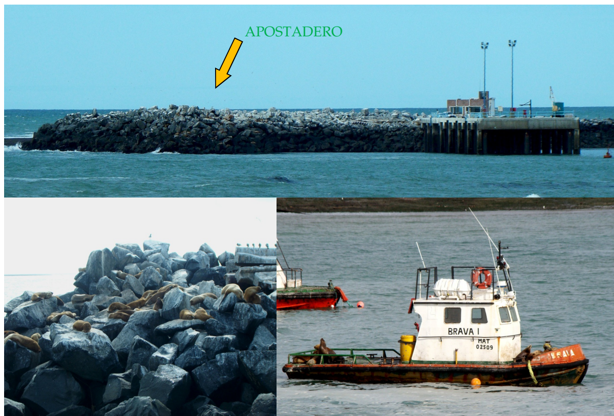
Figura N° 80: Puerto de Caleta Córdova
